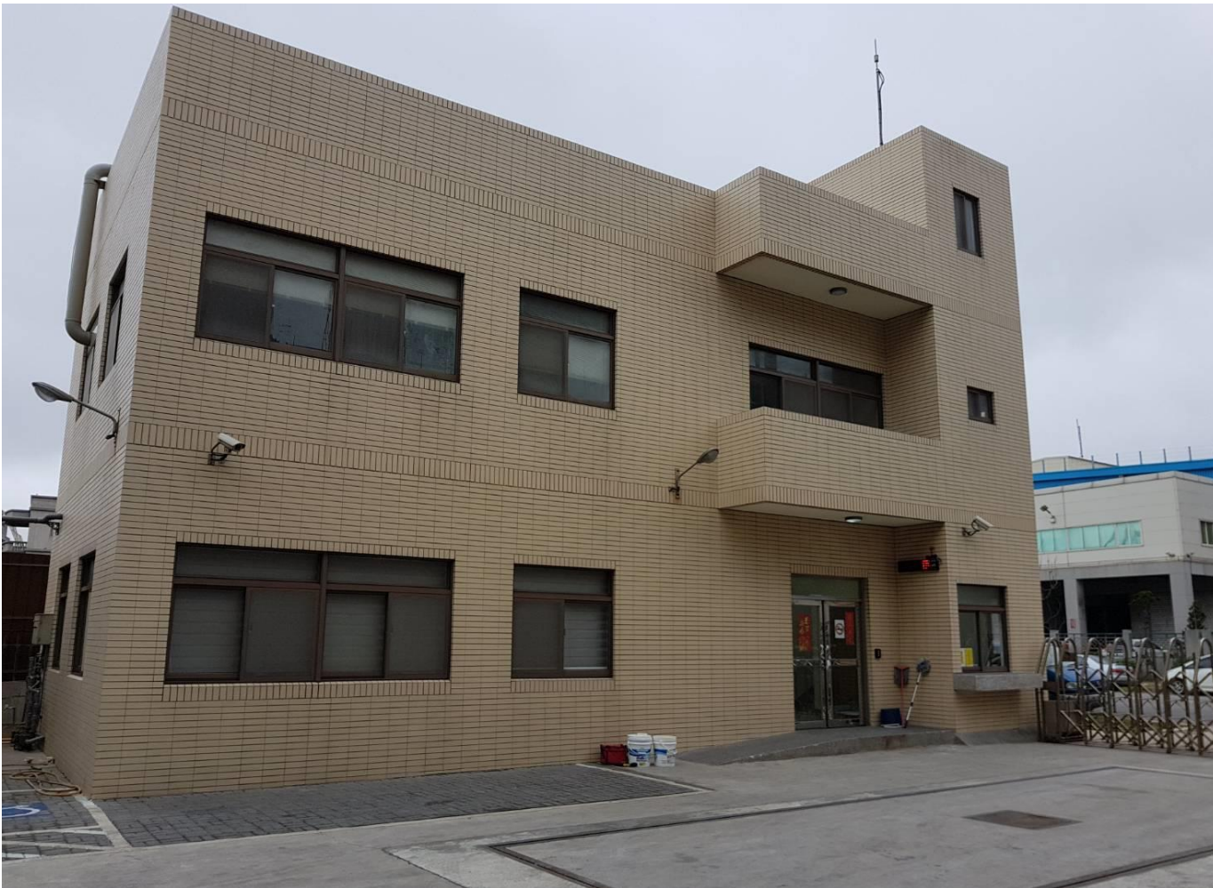
嘉德技術廠房新建工程（桃科）
